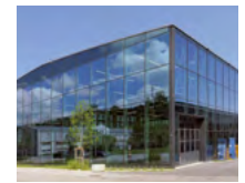
66 Werkhalle Glas Trösch, St.Gallen/CH
